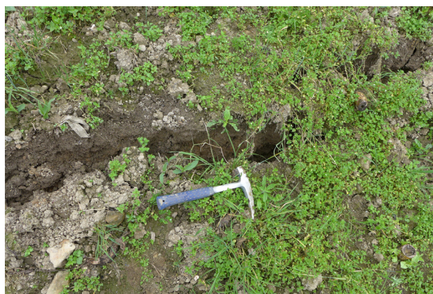
图 2e 林峡组古滑坡体顶部受地震影响开裂, 随降雨有扩大趋势
