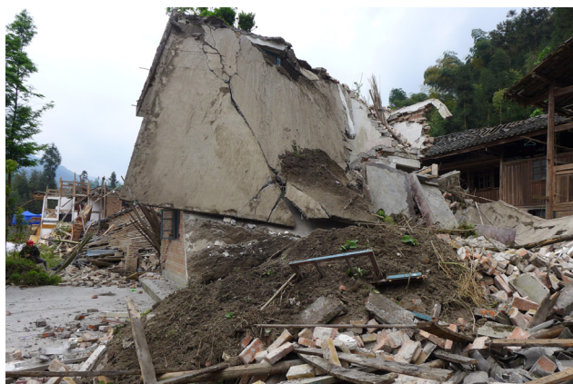
图 2b 双石镇砖混结构楼房倒塌
