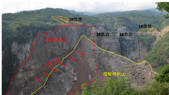
图 2 飞水沟滑坡全貌
